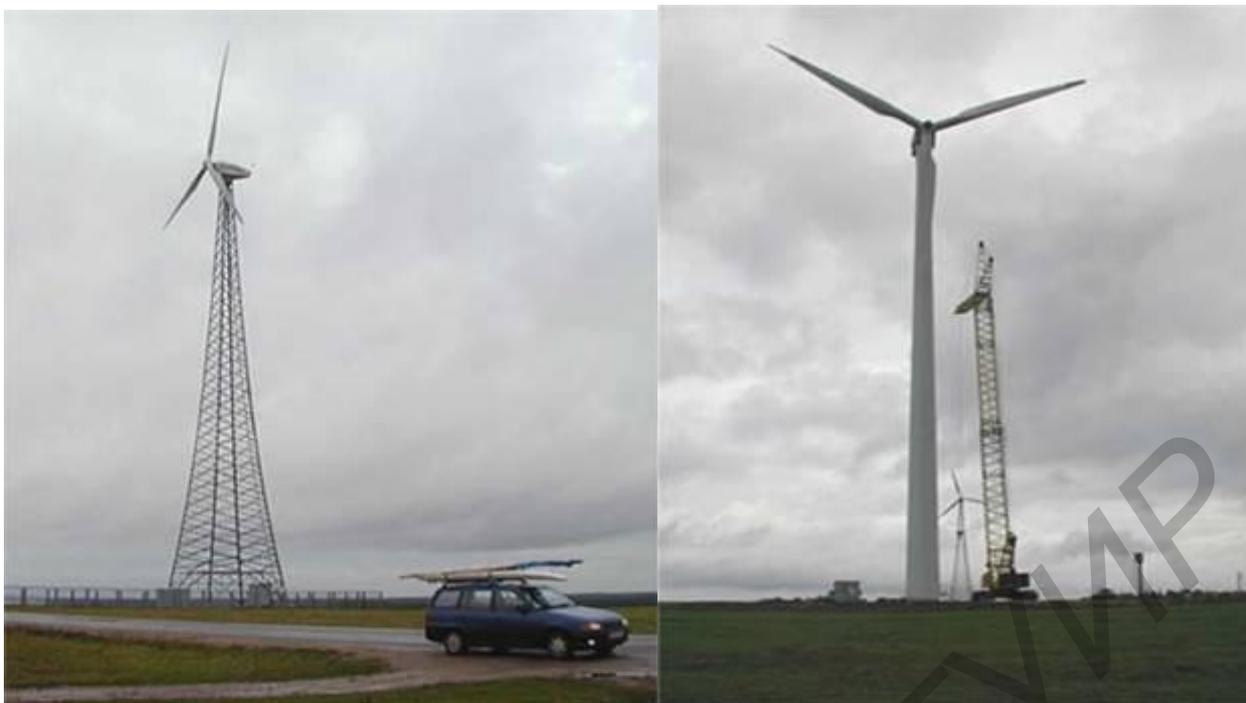
Рис. 7.8. Промышленные ВЭУ мощностью 250 кВт и 600 кВт около г.п. Занарочь (владелец – белорусско-немецкое общественное объединение «ЭкоДом»)
