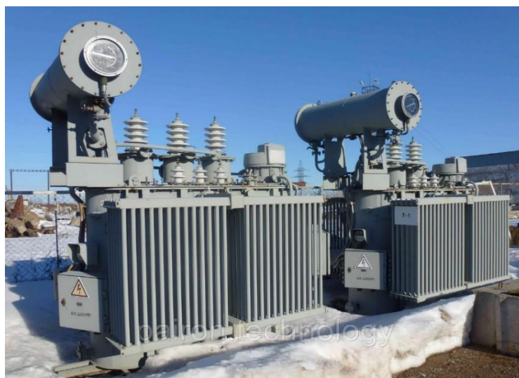
Рисунок 2. ПС «Городец» 35/10 кВ организации Кобринский РЭС Филиала Брестские Электрические Сети РУП «Брестэнерго»
