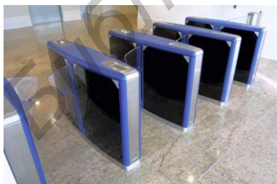
Рис. 6.34. Внешний вид турникетов с частичным перекрытием (а) и полным перекрытием (б) прохода
