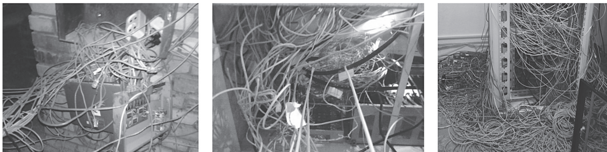
Рис. 1. Некорректно выполненный монтаж кабельной сети
