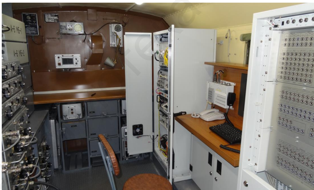
Рис. 54. Размещение оборудования в аппаратном отсеке станции
