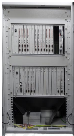
Рис. 57. Автоматическая телефонная станция АТСЭ ФММ
