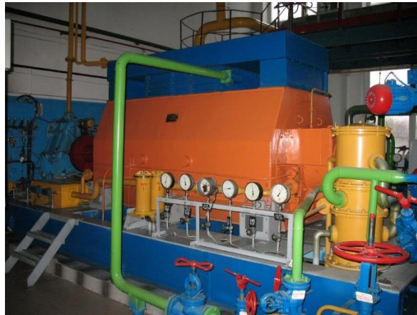
Рисунок 2. Редуктор и генератор ДГА
