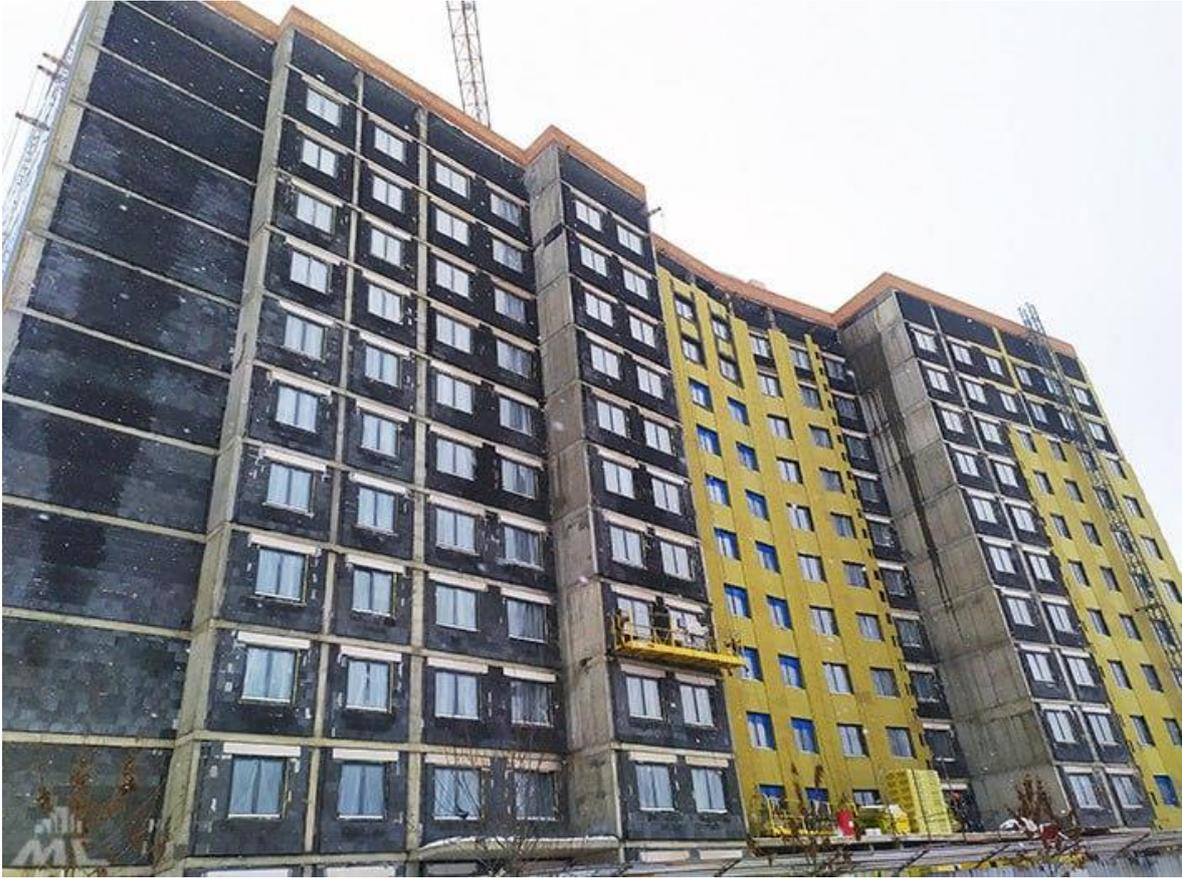
Продолжаются и возведение 20-этажного общежития БГУИР: монолитчики трудятся на уровне 15-го этажа. Одновременно каменщики заполняют стеновые проемы керамзитобетонными блоками на 10-м этаже. Кроме того, продолжается установка окон в здании. В ближайшее время будет закрыт контур трехэтажной стилобатной части, соединяющей два жилых корпуса, а затем приступят к штукатурным работам.
