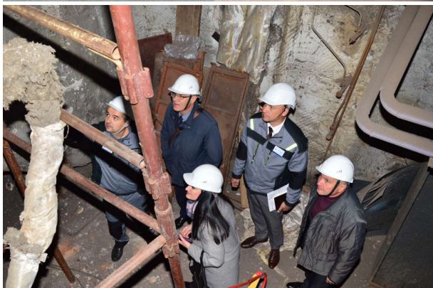
Рисунок 3 – Посещение преподавателями энергетического факультета Гомельской ТЭЦ-2 в период планового ремонта котлоагрегата
