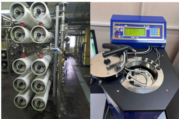
Рисунок 2 – Выполнение лабораторных работ по изучению системы обратного осмоса и определению теплоты сгорания топлива на Гомельской ТЭЦ-1
