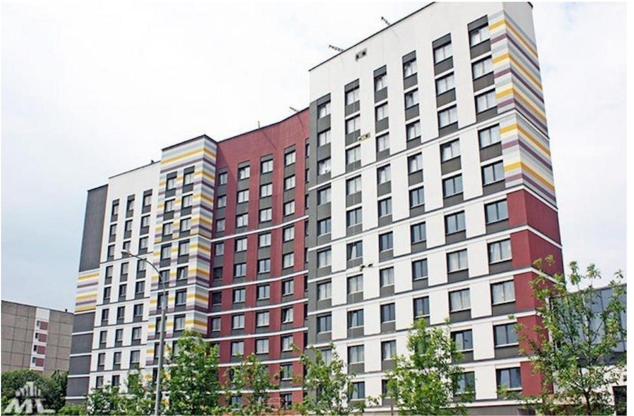
— В большей степени готовности находится 11-этажный корпус общежития БГМУ. Здесь завершаем покраску фасада, внутри в один слой покрашены акриловой краской помещения. Второй слой будет нанесен непосредственно перед установкой мебели, которую ждем.
