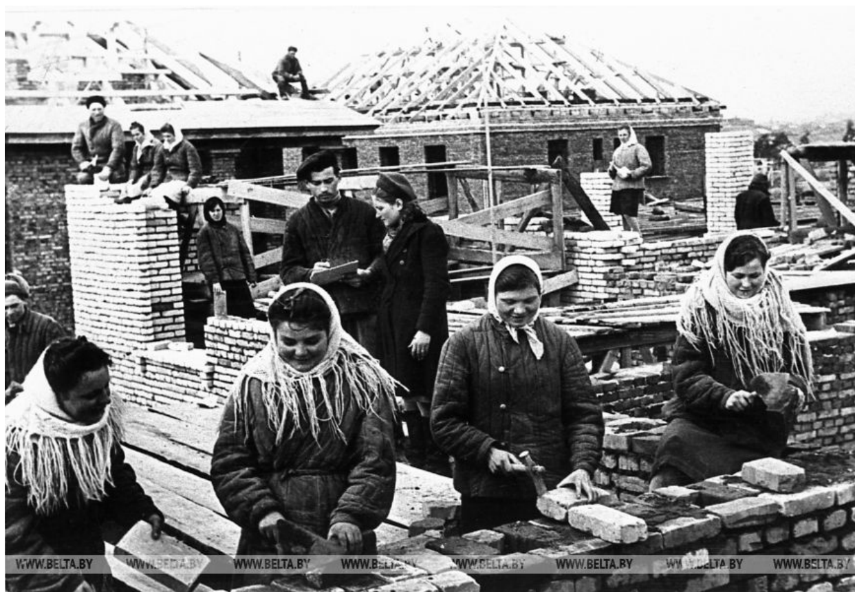
На строительстве жилых домов в рабочем поселке Минского автозавода, 1 декабря 1947 года.
