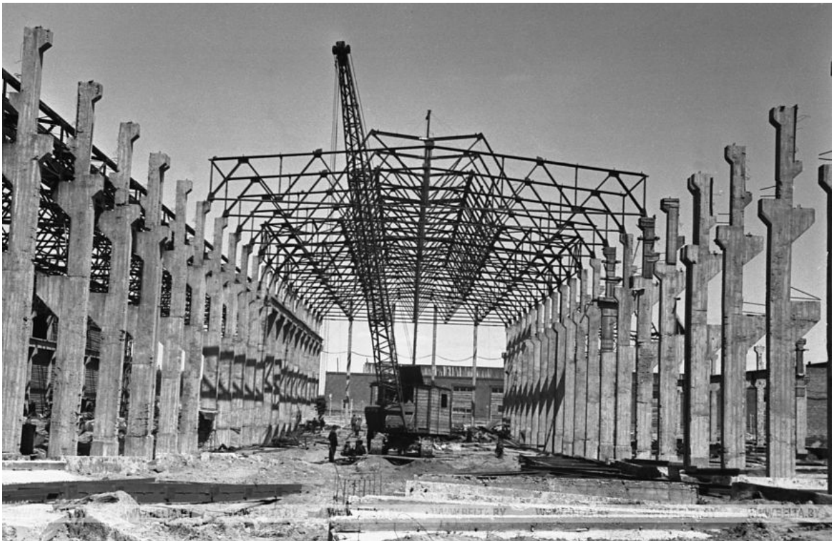
Строительство Минского тракторного завода, 1947 год.
