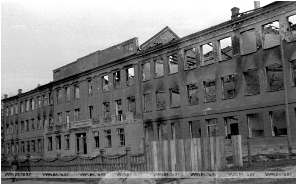
Здание школы № 18 в Бобруйске, разрушенное во время войны, 1 июля 1947 года.
