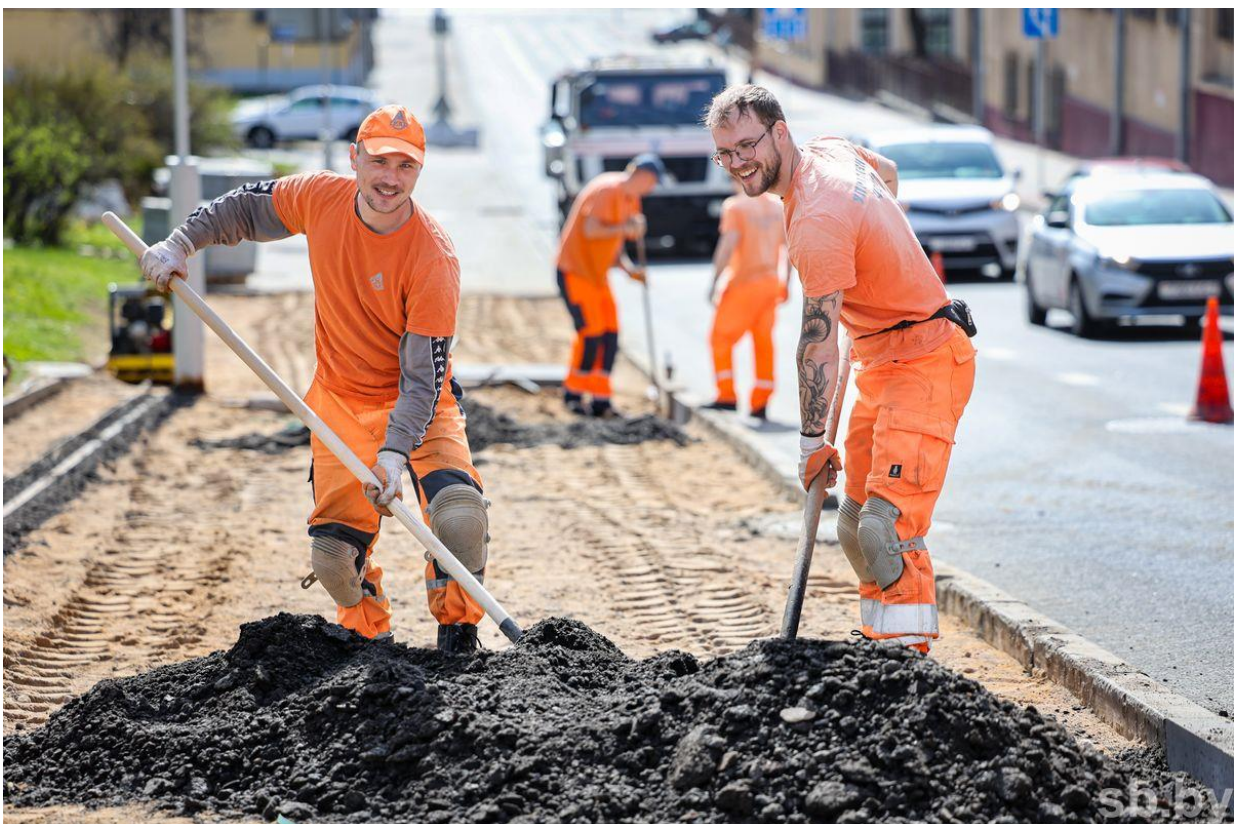
Асфальтобетонщики ГПО «Горремавтодор Мингорисполкома» Артем Новицкий и Даниил Агарак ремонтируют столичные дороги. Фото Елизаветы Кобецкой
