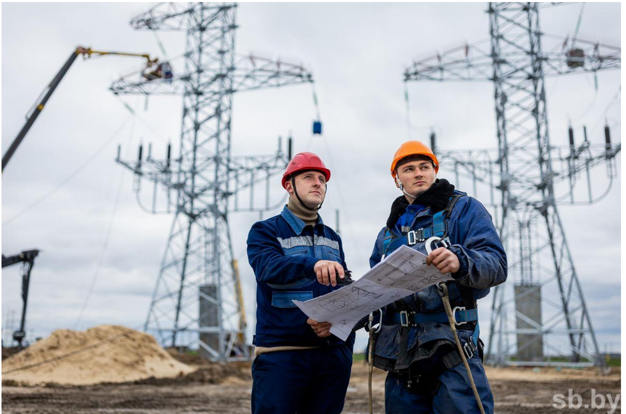
Мастер строительно-монтажных работ филиала «Механизованная колонна-87» ООО «Западэлектросетьстрой» Сергей Масловский и электромонтер-линейщик Евгений Семейко на строительстве новой ЛЭП Мозырь — Микашевичи. Фото Ивана Яривановича
