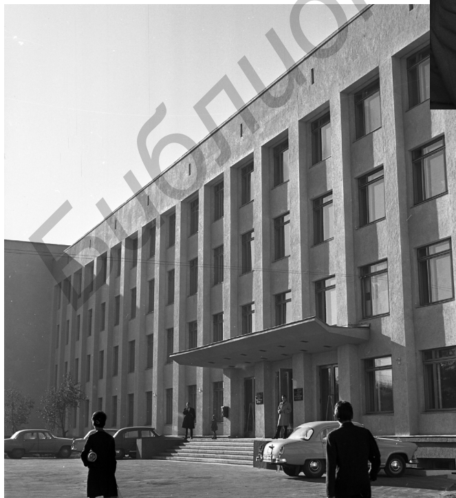
Здание 1-го корпуса МРТИ, 1964 г.
