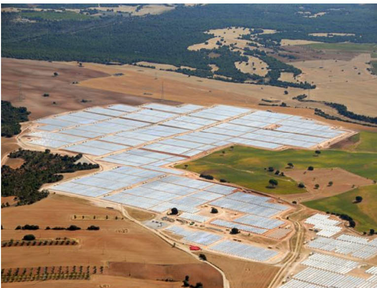
Рис. 5 – PV-станция Solar Park Olmedilla, Испания [6]
